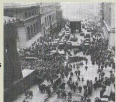
Crack de la bourse à New-York
